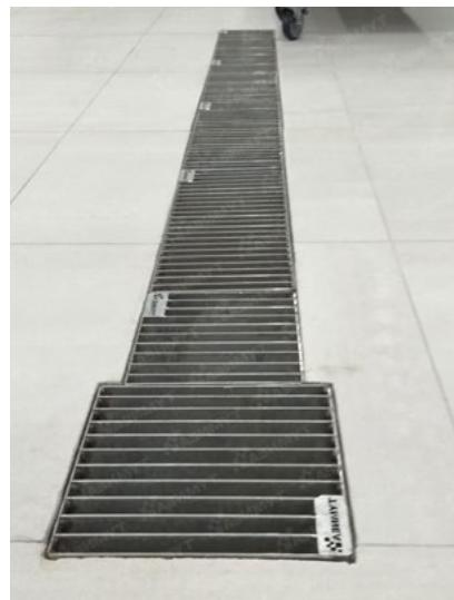
**Покрытие трапов (AISI 304 / AISI 316L)**
